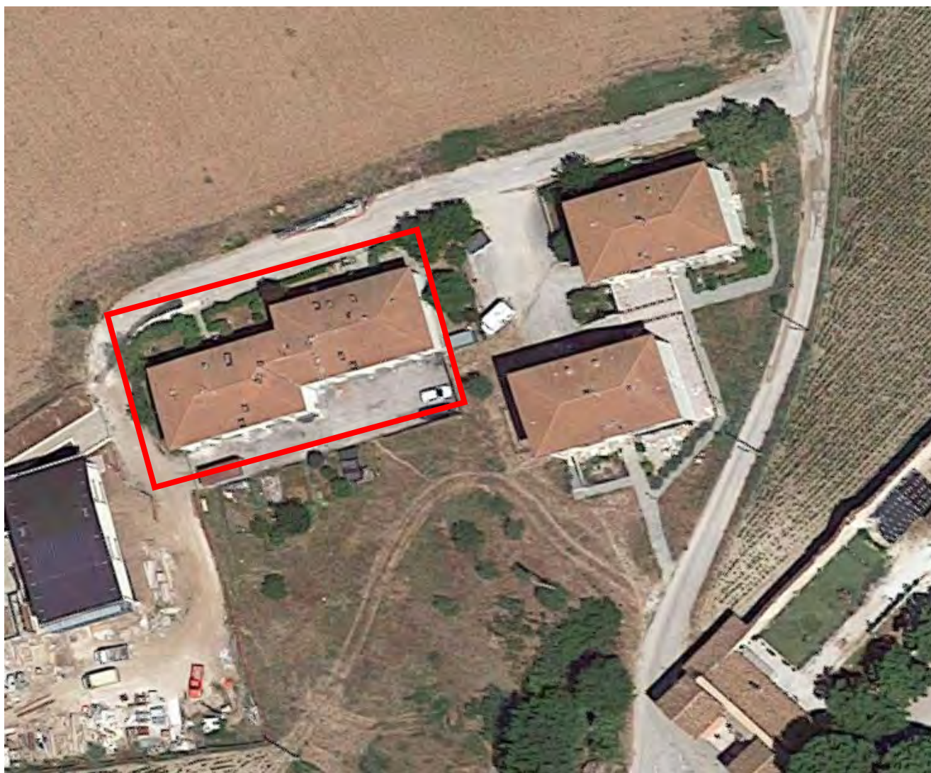
Vista aerea dell'edificio
